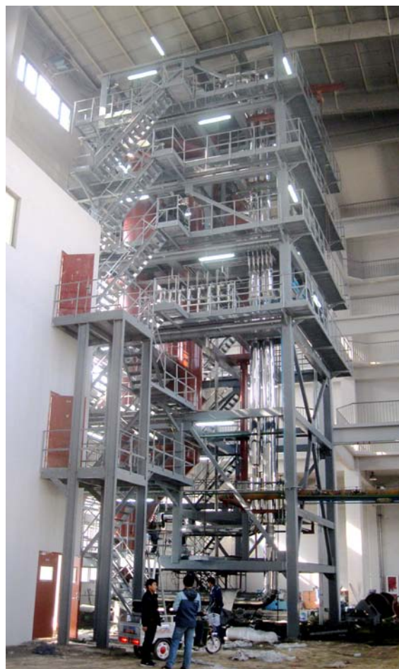
5t/d 气化试验台
