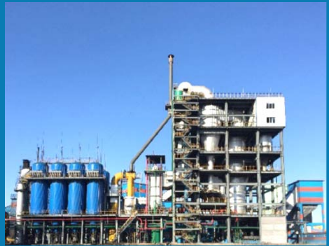
60000Nm 3 /h 空气气化项目
