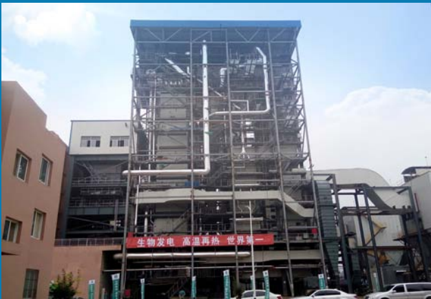
130t/h 超高压再热生物质循环流化床锅炉
