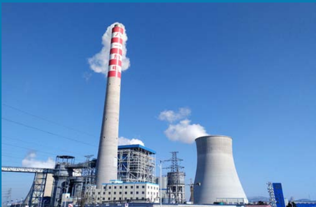
350MW 超临界循环流化床燃煤锅炉
