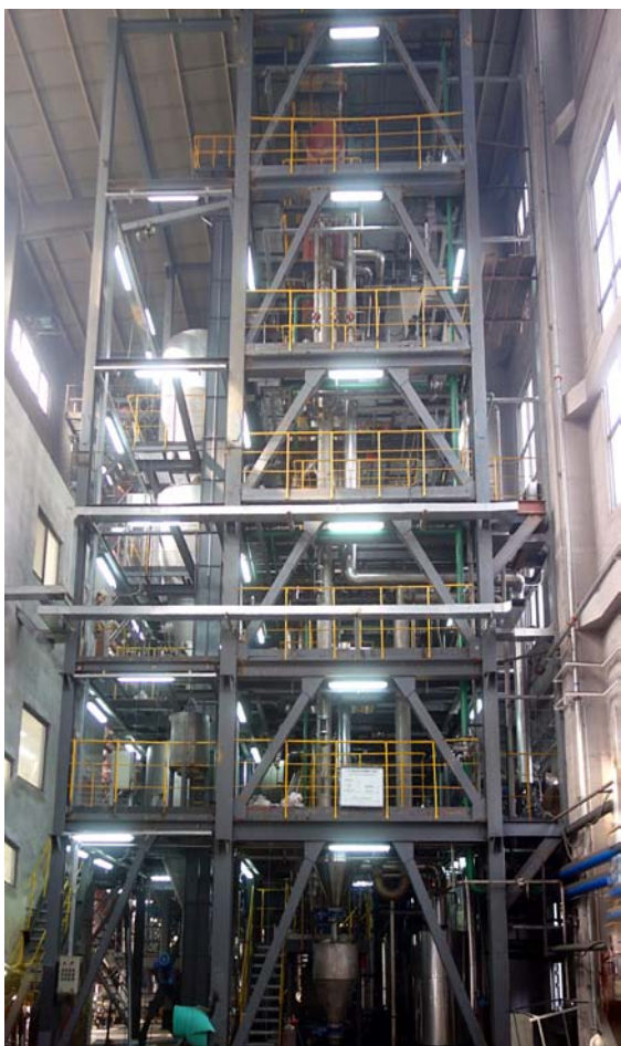
2MW 燃烧试验台
