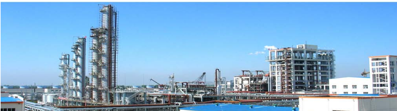
首座煤基甲醇和燃气轮机发电联产系统
